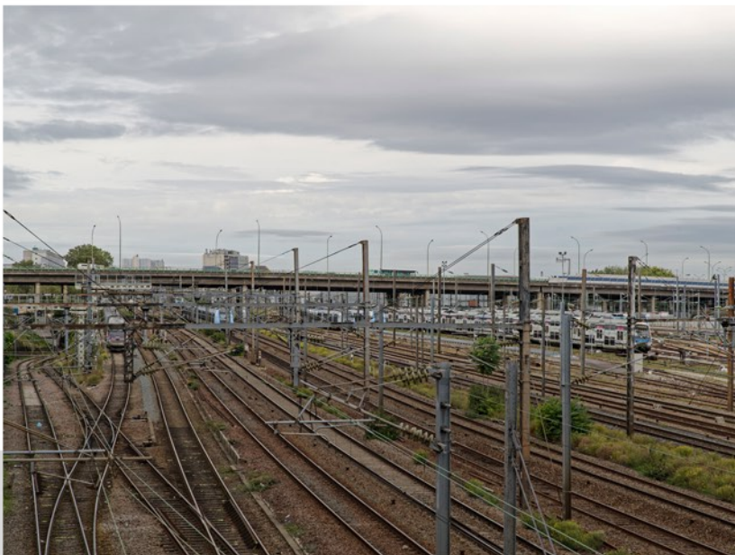
...und hier geht es über das Depot der Linie RER E. ... et ici, je suis guidé sur des supports au-dessus du Dépôt de train RER E.
